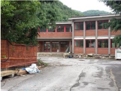
Vobarno Riaperto il cantiere per il polo scolastico
